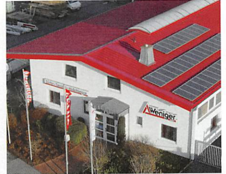
Besichtigung des Gastgeberbetriebs „Weniger Bedachungen“
